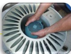
Motor sendo colocado no espaço e o cabo sendo puxado até a caixa de ligação.
