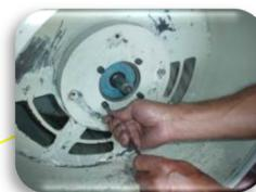
Fixando o motor no flange. Antes já foi colocada cola 3M para juntas no flange e nos quatro parafusos que fixam o motor na carcaça.
