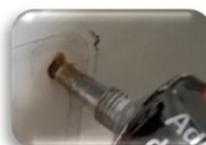
Colocar os parafusos e as arruelas de pressão nos furos com cola 3M.
